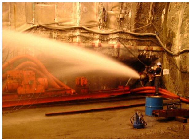
水抜き孔から吹き出す水
