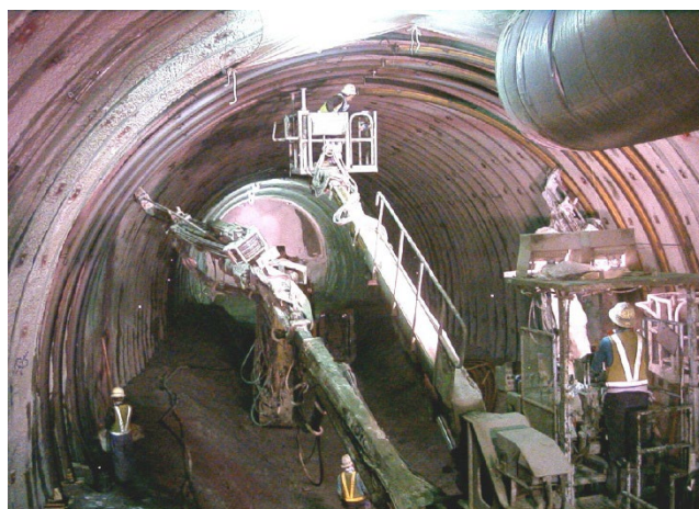
多重支保工法（崩れやすい山の掘削に対応）
