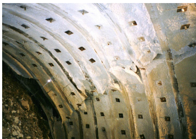
山の押し出しにより破断したトンネル側壁
