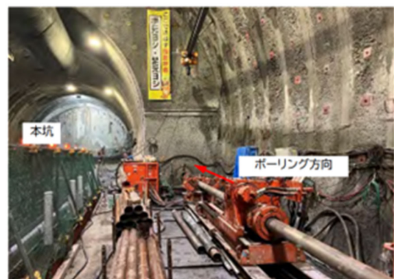
台場山工区ボーリング削孔状況
