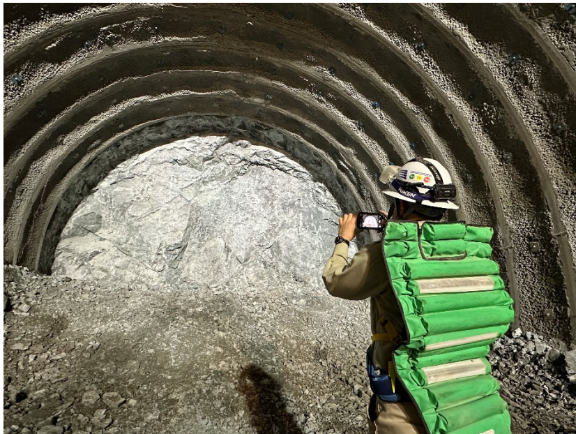
<切羽掘削面の映像をトンネル坑外の事務所とやりとりする様子>
