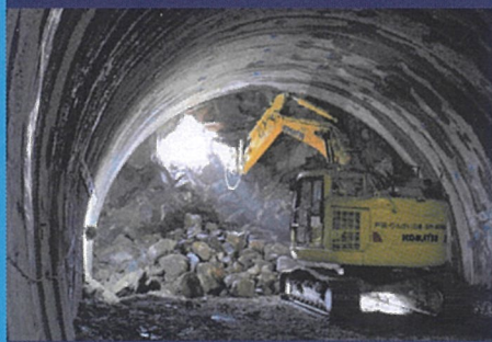
貫通した二股トンネル
