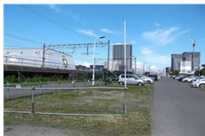
②施工ヤード予定地付近 （終点方を望む）
