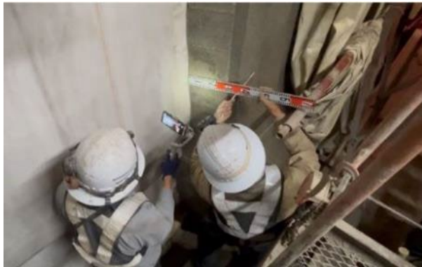
写真2：覆工コンクリート巻厚測定の写真状況と確認者側の映像
