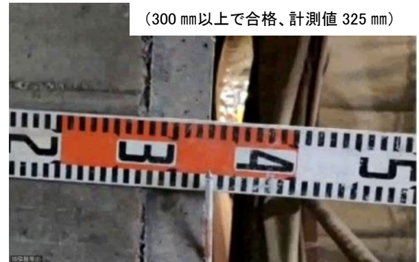
写真2：覆工コンクリート巻厚測定の写真状況と確認者側の映像
