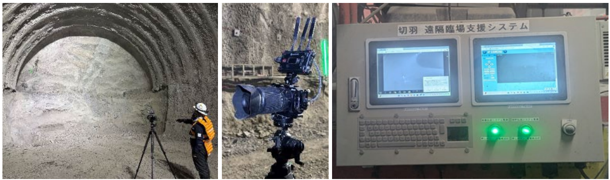
写真1：切羽を撮影する様子と一眼レフカメラと遠隔臨場支援システム PC
