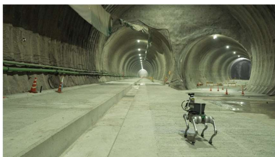
<四足歩行ロボットがトンネル坑内を3Dスキャンする様子>
