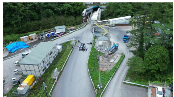
<ドローンがトンネル坑外を3Dスキャンする様子>
