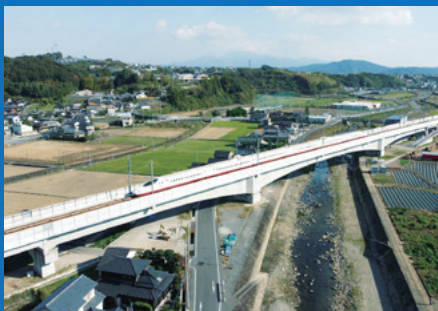
新幹線鉄道等の 鉄道施設の建設
