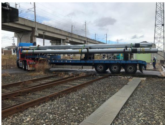
電化柱の運搬状況
