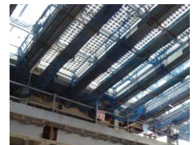
小田急小田原線 下北沢駅 自然採光と太陽光パネル
