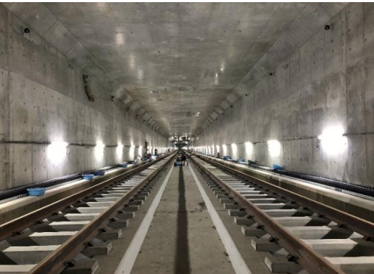
▲綱島トンネル
