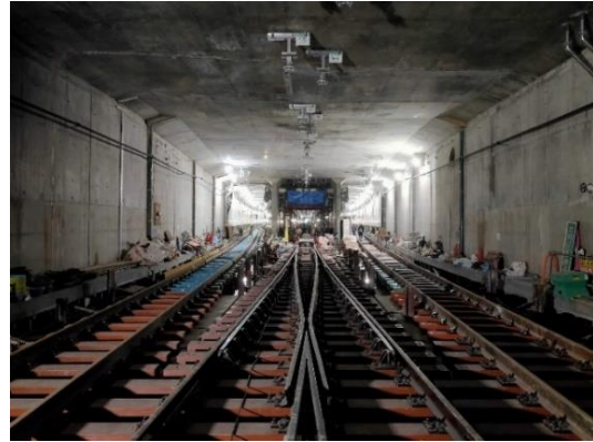
▲羽沢トンネル
