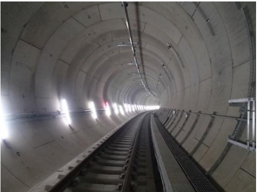
▲綱島トンネル
