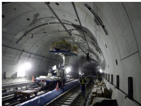
▲新横浜トンネル
