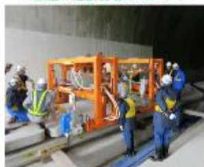
民間企業と連携して軌道スラブ調整作業の電動化
