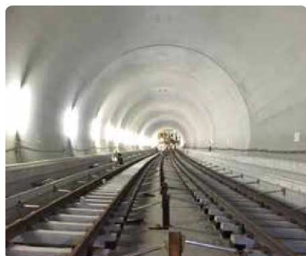
相鉄・JR直通線 西谷トンネル
