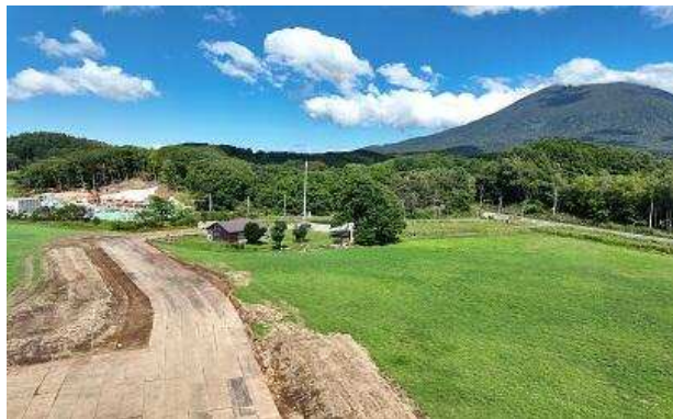
羊蹄トンネル（有島）（ニセコ町） 地上部
