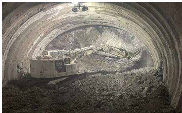
渡島トンネル（南鶴）（北斗市・厚沢部町） トンネル掘削状況
