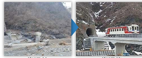
復旧前 復旧後
