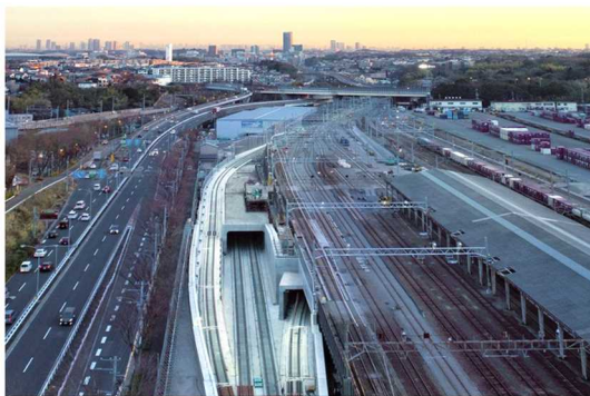
写真 1.1.4-1 連絡線の完成状況 (羽沢横浜国大駅から都心方面)
