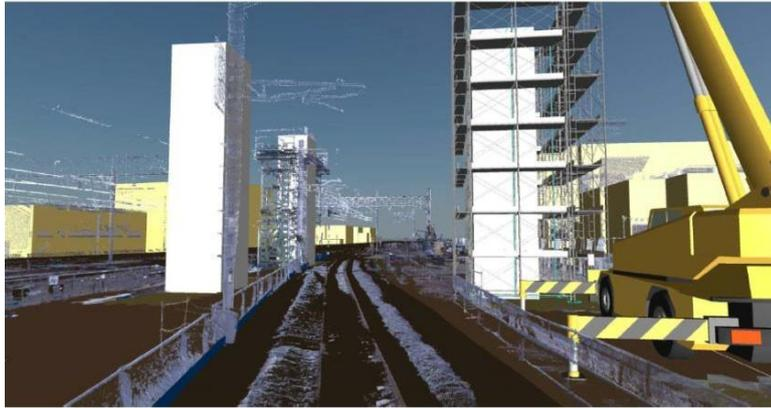
図 3. 5 鉄道事業者との協議の例（門型橋脚施工時の運転士目線の確認）
