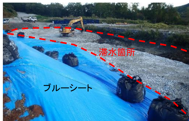
滞水箇所の埋戻し状況(R3.10.6撮影)
