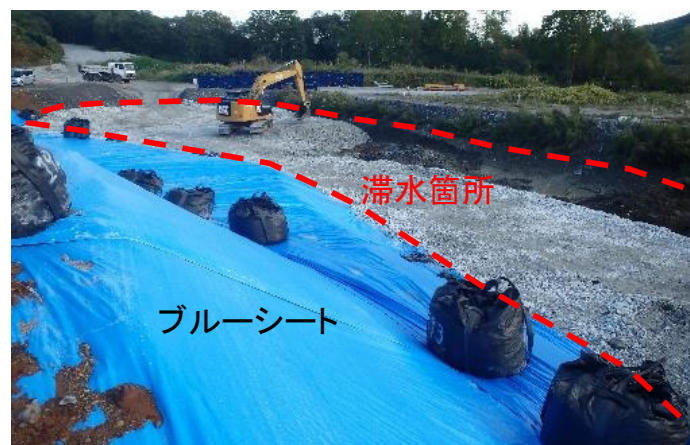
滞水箇所の埋戻し状況 (R3.10.6 撮影)
