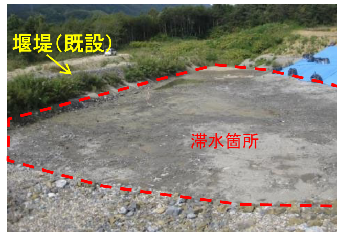
滞水箇所の汲み上げ実施状況 (R3.9.21 撮影)
