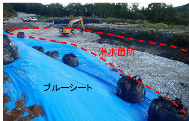
滞水箇所の埋戻し状況(R3.10.6 撮影)
