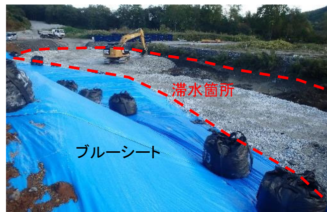
滞水箇所の埋戻し状況(R3.10.6撮影)
