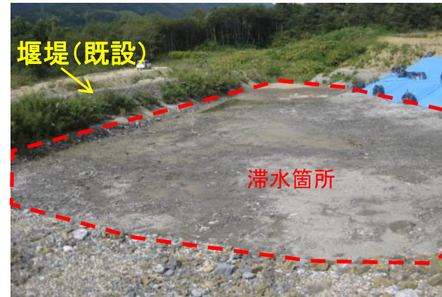
滞水箇所の汲み上げ実施状況(R3.9.21 撮影)
