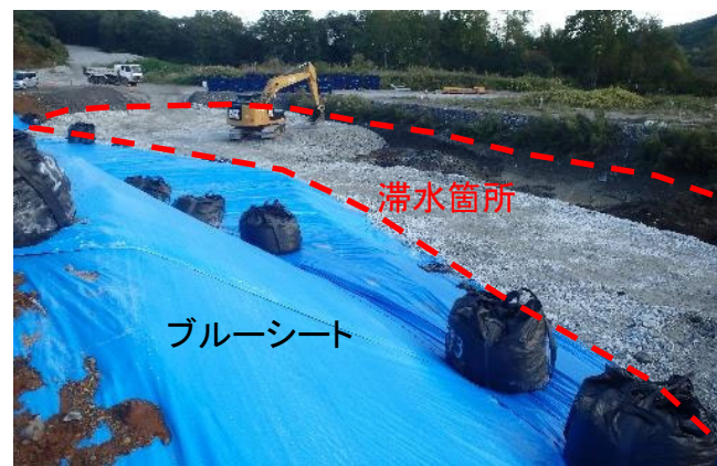
滞水箇所の埋戻し状況(R3.10.6 撮影)
