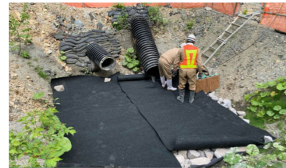
【集水桝への対応】 重金属吸着マットの設置
