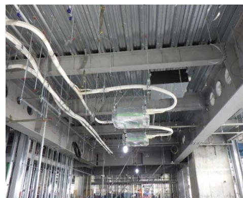
▲2階作業員用更衣室の空調設備
