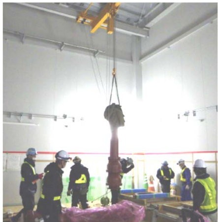
▲西部消雪基地 送水ポンプ据付
