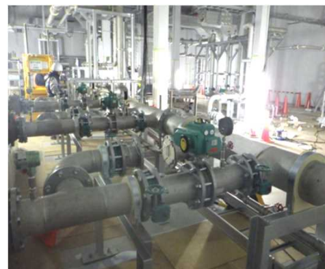
▲西部消雪基地 ポンプ室内配管
