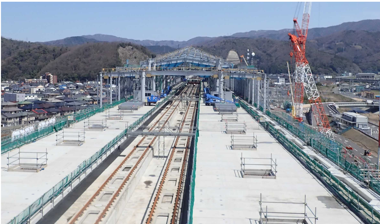
旅客上家 鉄骨建方状況（終点方から起点方を撮影）
