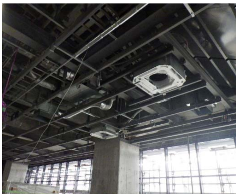
▲待合室(コンコース)の空調設備
