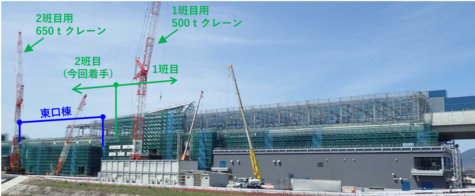
工事状況（東側）
