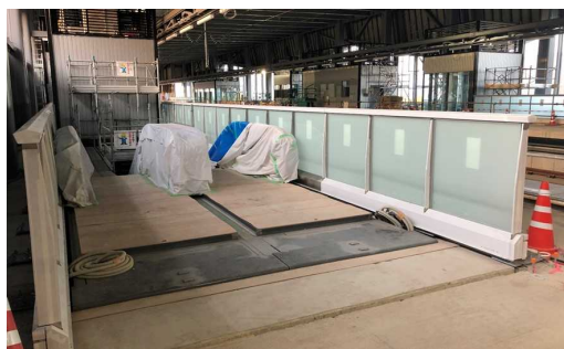
ホーム階 (エスカレーター付近)▶
