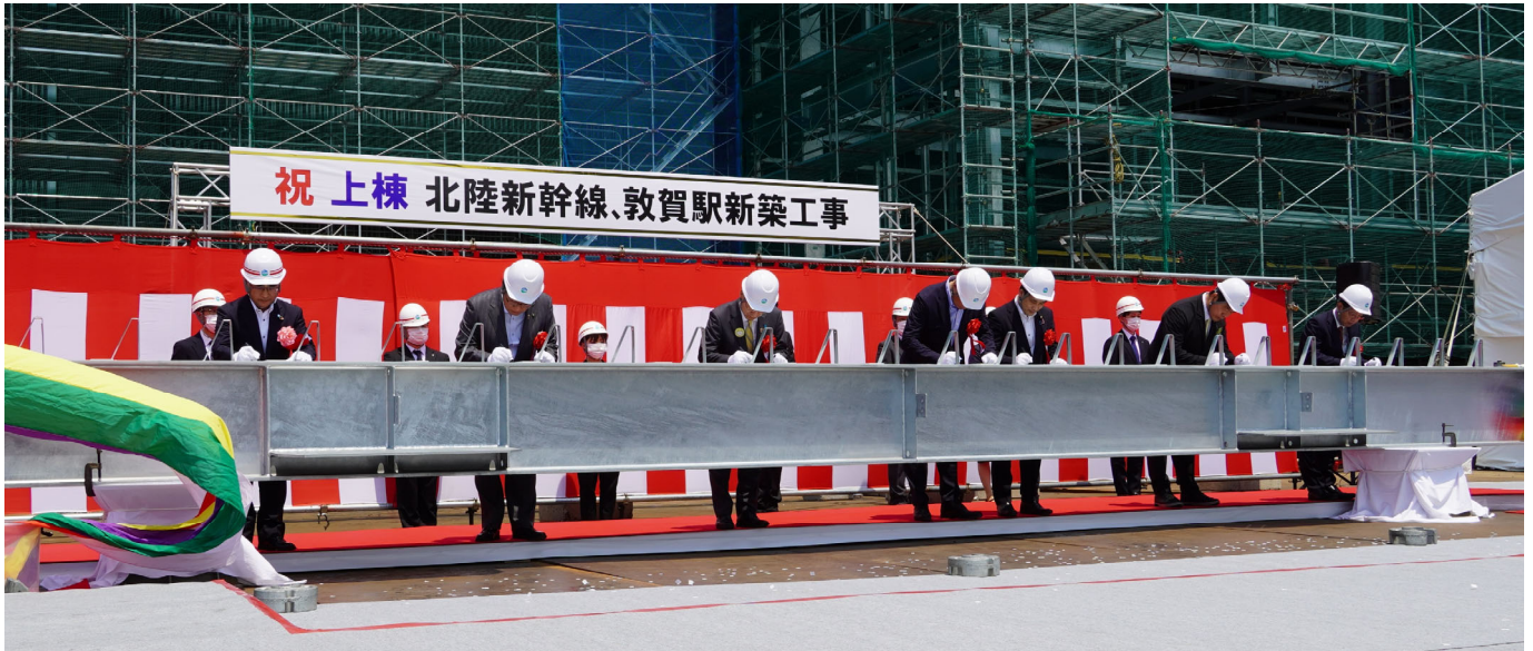
棟上げする鉄骨梁に署名する様子
