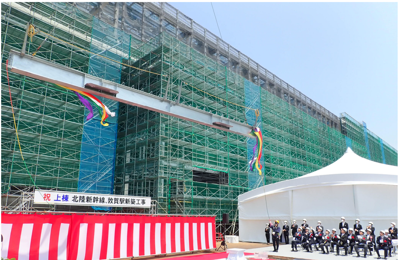
鉄骨梁を吊り上げる様子
