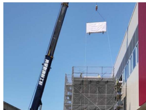
ホーム階 (エスカレーター付近)▶
