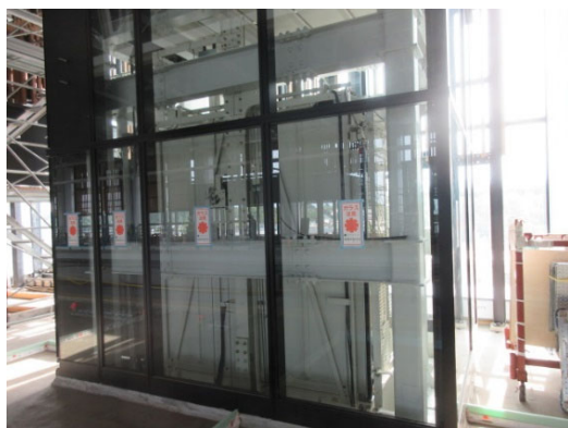
▲エレベーター かご設置
