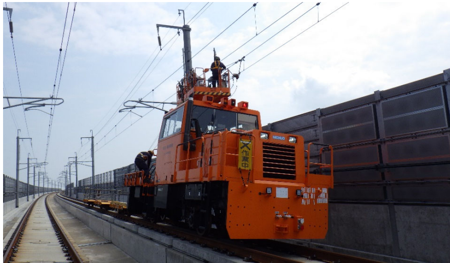
電車線調整作業状況写真
