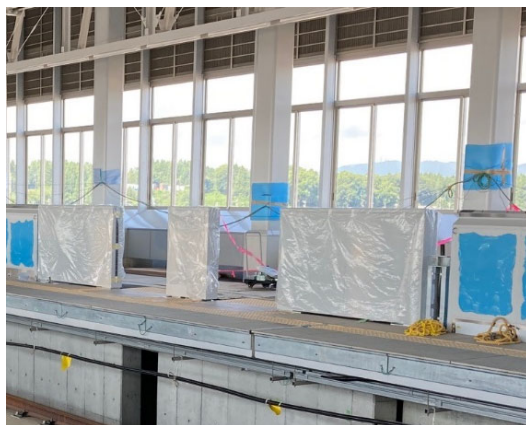
▲下りホーム 可動式ホーム柵据付
