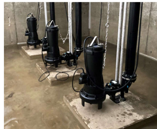
▲西部消雪基地 水中ポンプ据付
