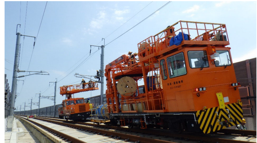
電車線設置作業状況写真
