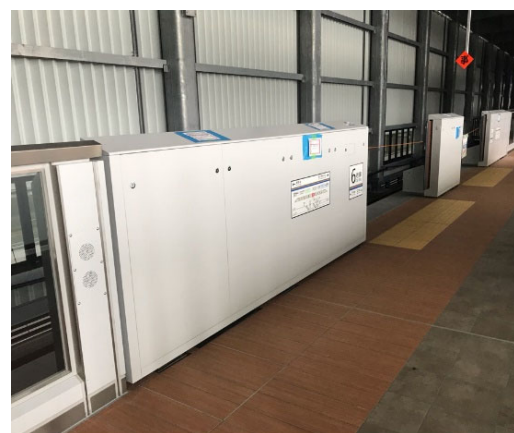
▲上り線 可動式ホーム柵据付
