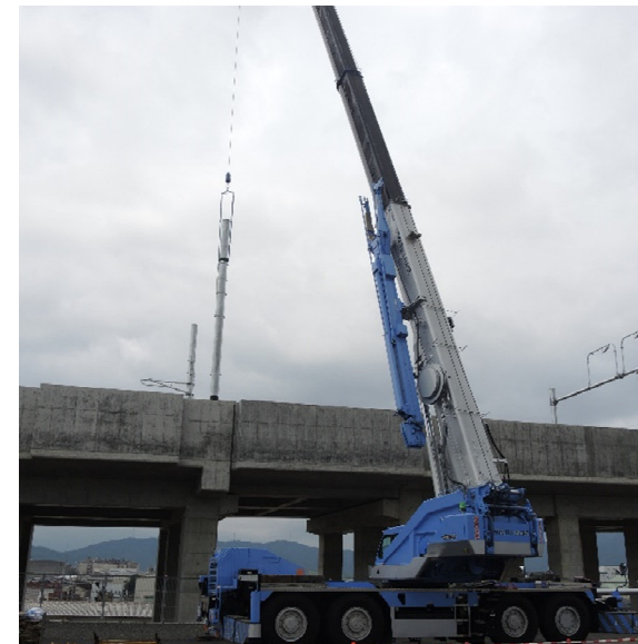
電柱設置作業状況写真
