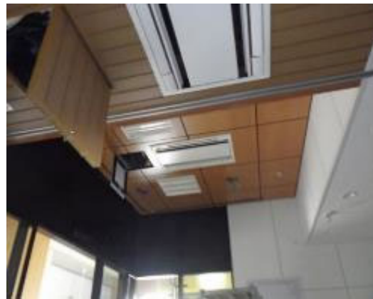
▲みどりの窓口 空調機据付
