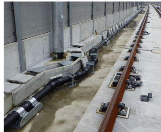
▲駅西部 消雪配管据付(高架上)
