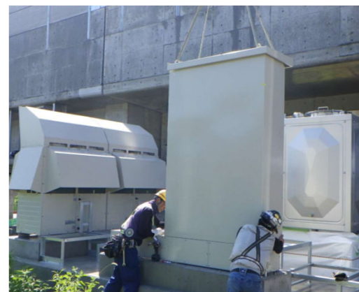
▲ 駅西部温水ジェット 動力制御盤据付 1階コンコース (改札付近)▶
