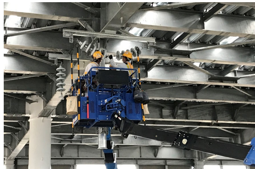
電車線支持物設置作業状況写真
