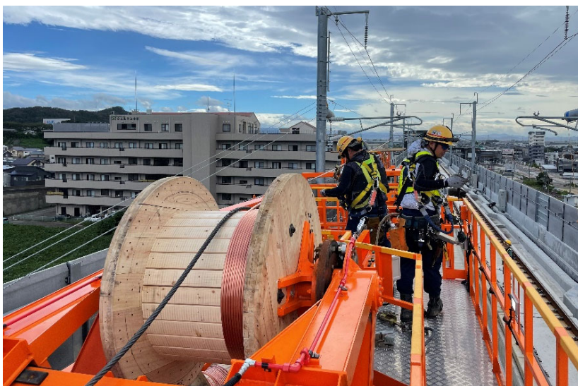
電車線設置作業状況写真
