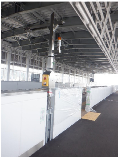
▲出発進路開通表示灯自立柱設置
