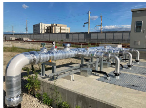
▲西部消雪基地 配管設備(水槽上)
