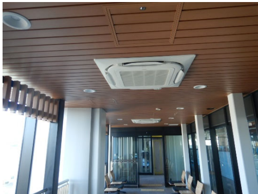
▲ホーム上待合室照明設置
