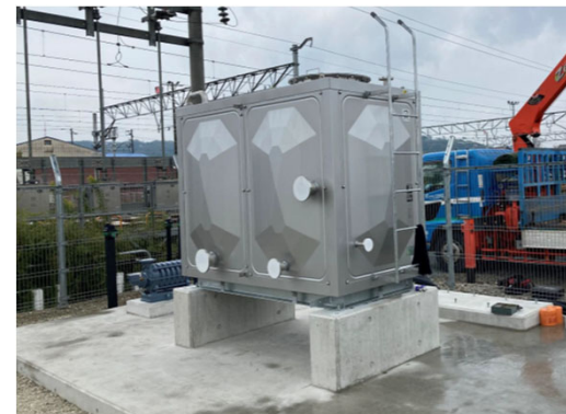
▲西部温水ジェット 貯湯槽据付
