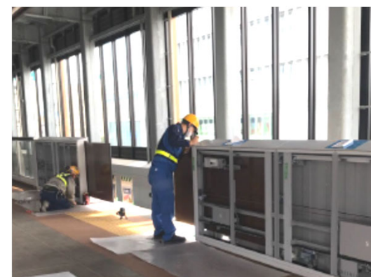
▲下りホーム 可動式ホーム柵試運転調整
