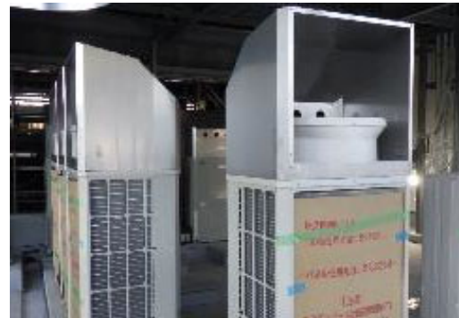
▲東口棟1F 空調室外機 搬入・据付
