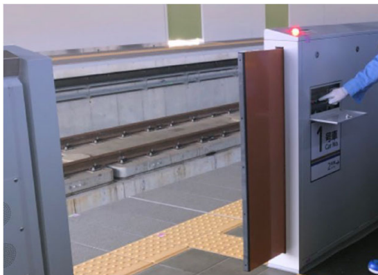
▲上りホーム 可動式ホーム柵試運転調整
