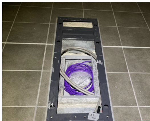
▲ 自動改札機用配線敷設
