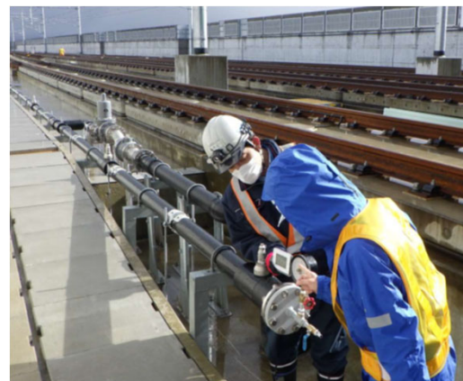
▲ 消雪配管気密試験(高架上)
