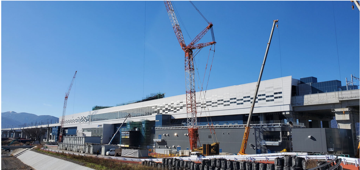
敦賀駅 外観（東側）
