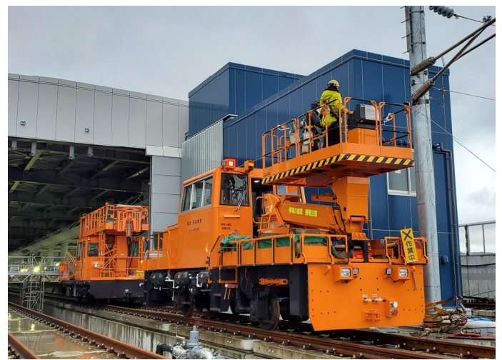
電車線設置工事状況
