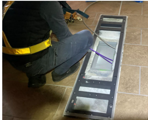
▲ 自動改札機用配線敷設
