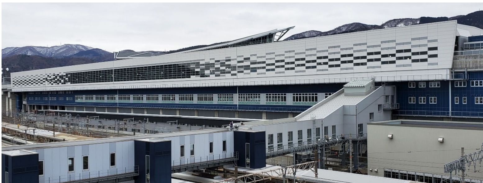
敦賀駅 外観（西側）
