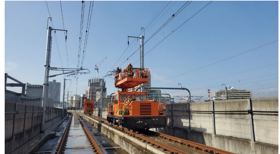
電車線調整作業状況写真
