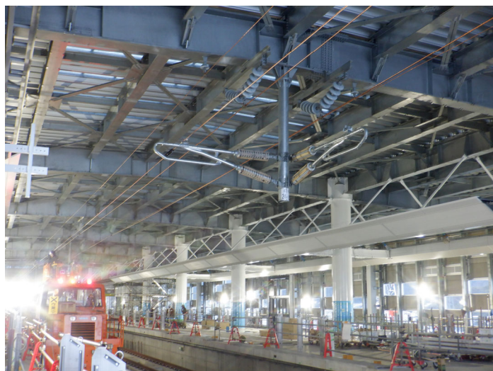
電車線施工状況
