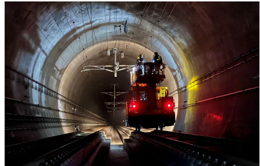
電車線調整作業状況写真
