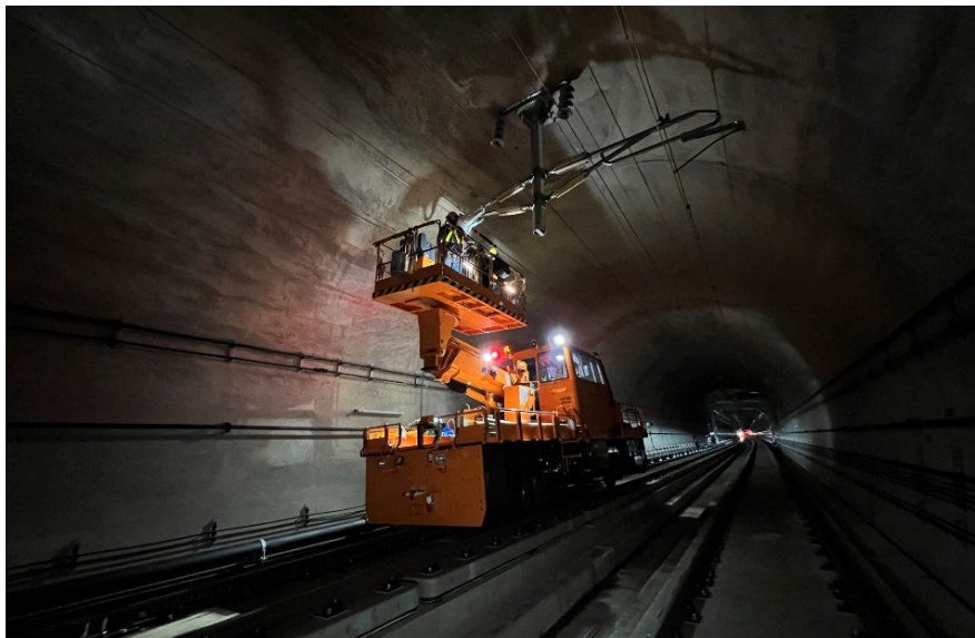
電車線調整作業状況写真
