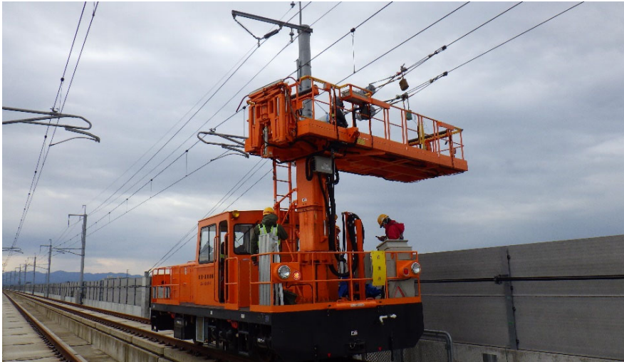
電車線調整作業状況写真
