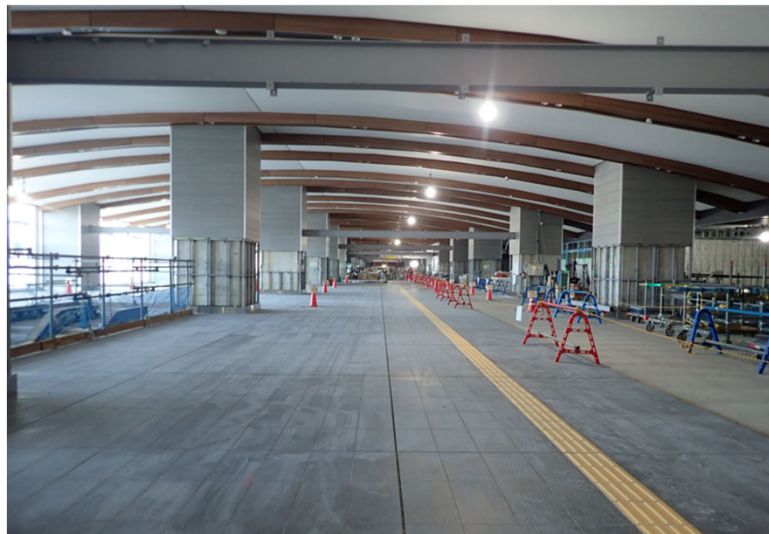
中層階（コンコース階） 施工状況
