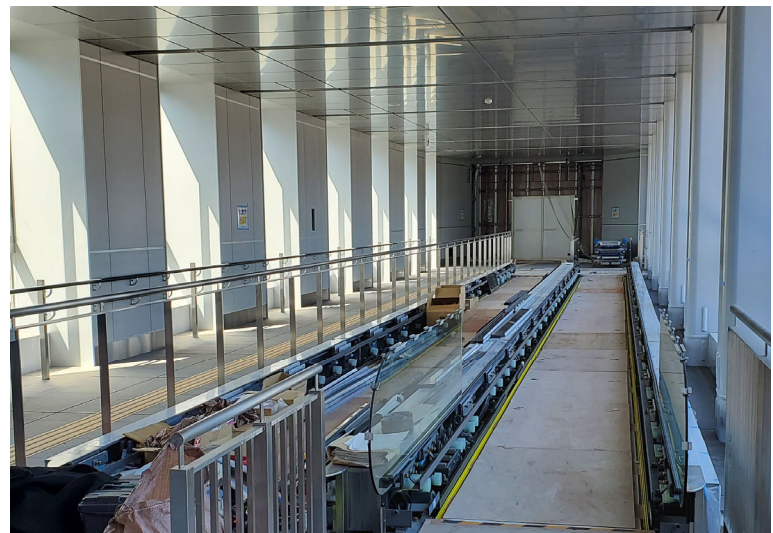
MW 施工状況（福井県より受託）
