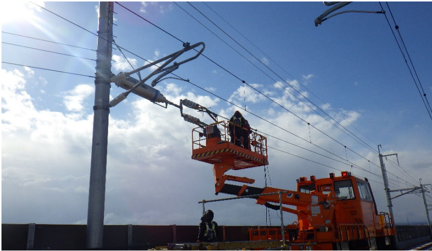
電車線調整作業状況写真
