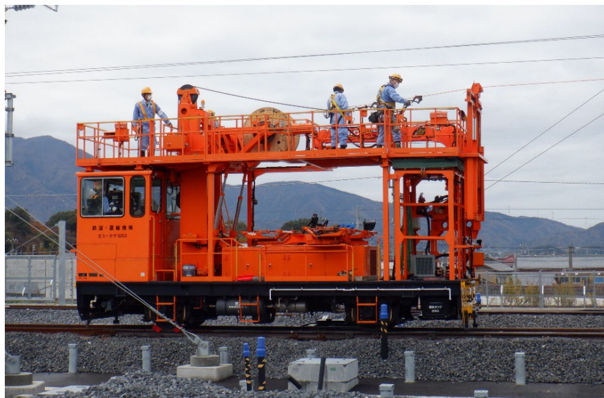
電車線設置作業状況写真
