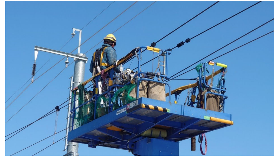
電車線調整作業状況写真
