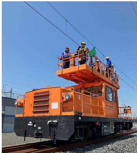
電車線の目視確認状況
