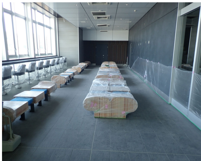
待合室（コンコース階） 施工状況
