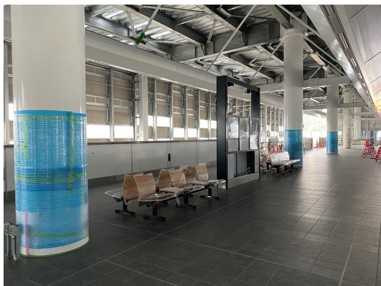
ホーム階 施工状況
