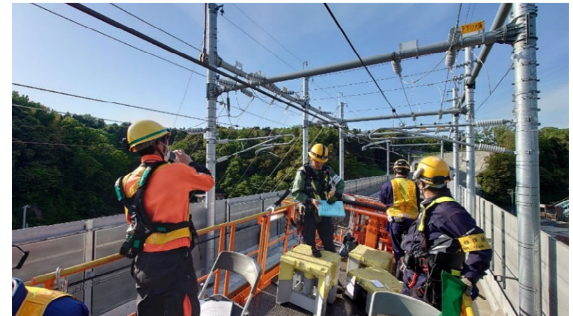
電車線の目視確認状況
