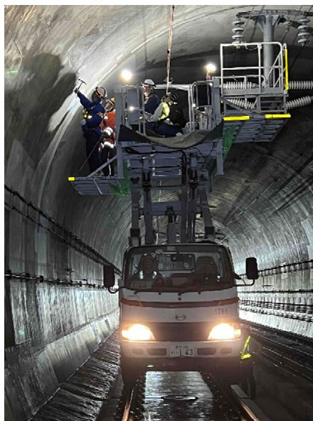
路盤部門 トンネル打音検査の実施状況
