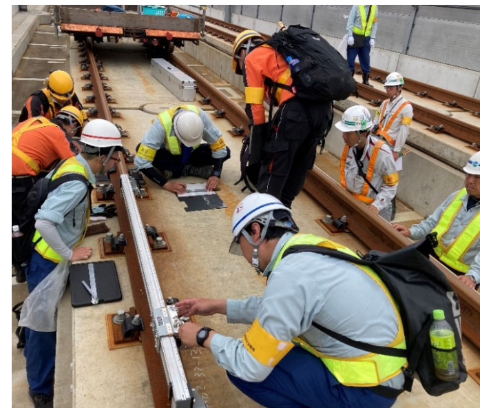
軌道部門 レール溶接面の確認状況
