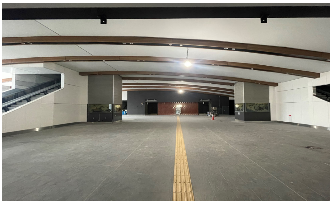
中層階（コンコース階） 施工状況
