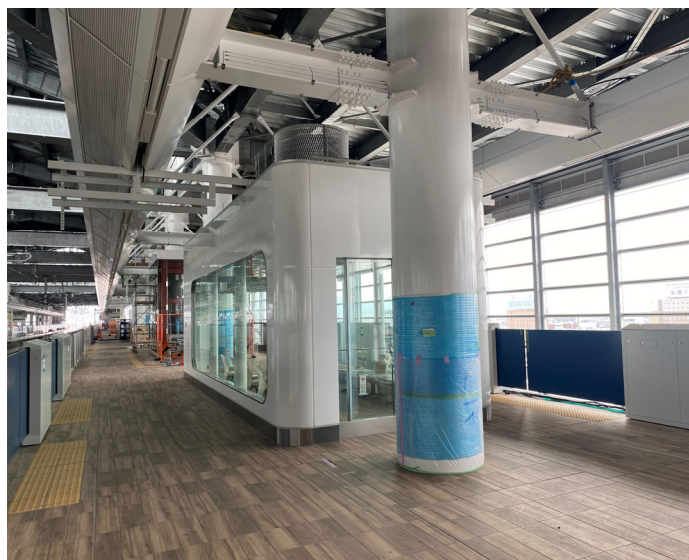
ホーム階 施工状況
