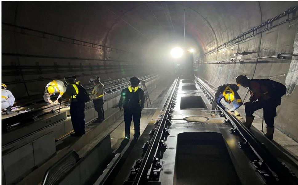
路盤部門 トンネル内施工基面幅の確認状況
