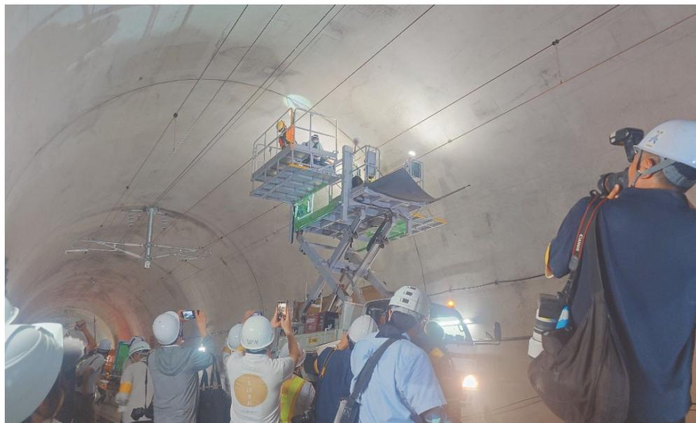
トンネル打音検査による確認状況
