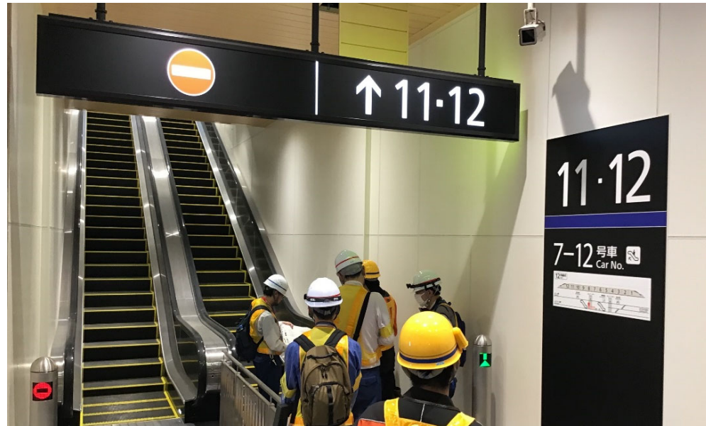
機械部門 エスカレータ動作確認状況
