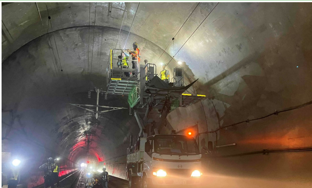
路盤部門 トンネル打音検査実施状況
