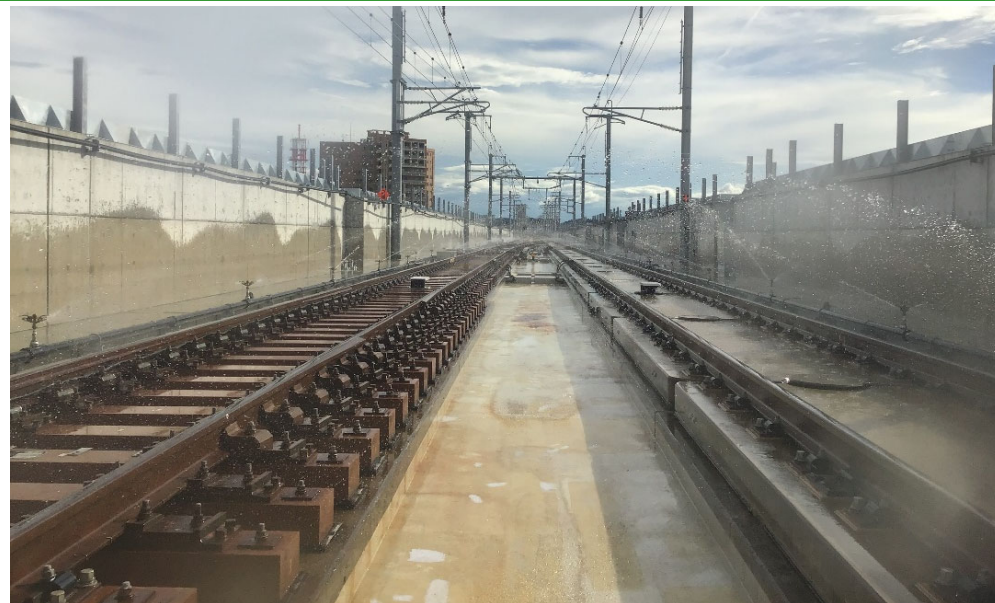
機械部門 散水消雪設備試験状況
