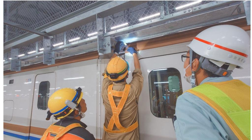
停工部門 パンタグラフ点検台と車両の離隔計測状況
