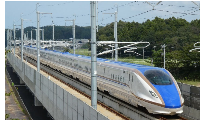
W7系電車走行状況
