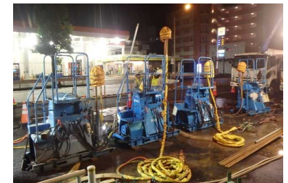
陥没箇所での注入による地盤強化状況
