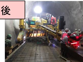
※3: 列車が走行する軌道を固定させるスラブをのせるために必要なコンクリート構造物
