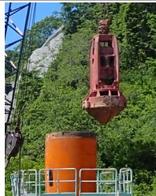
地上から鋼製の円筒を回転圧入し岩塊を撤去
