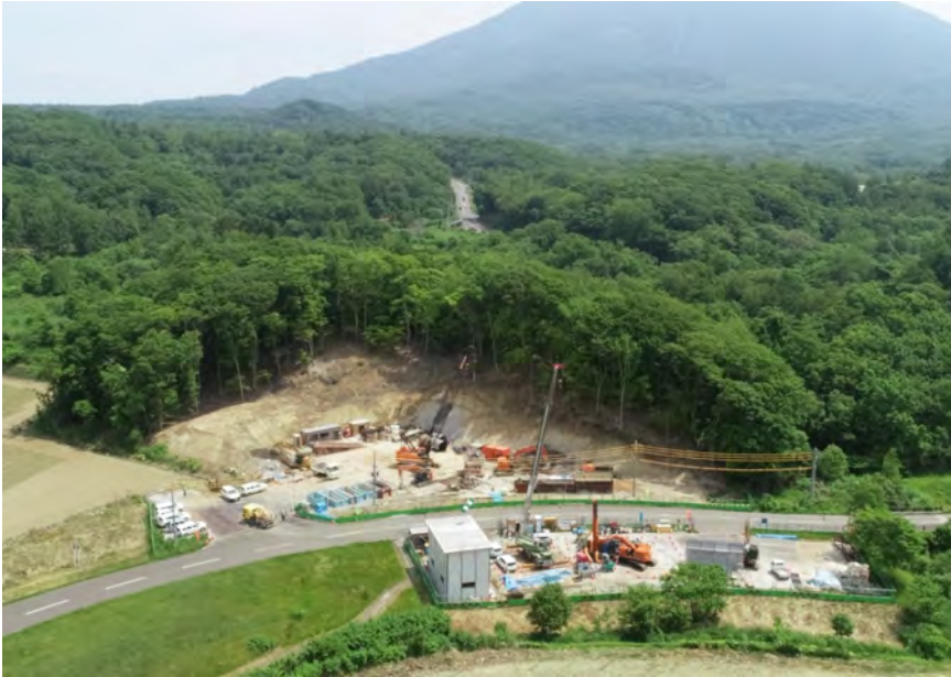
羊蹄トンネル(有島) 岩塊撤去状況
