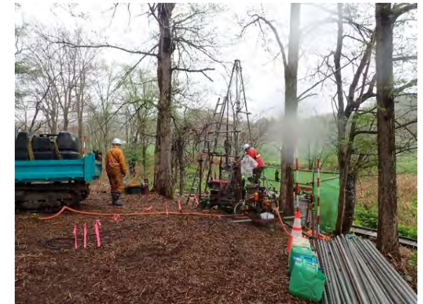
ボーリング調査状況
