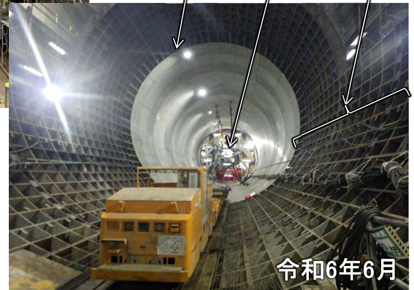
仮組セグメント （後日撤去）
