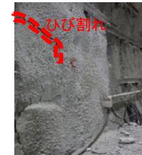
吹付けコンクリートのひび割れ
