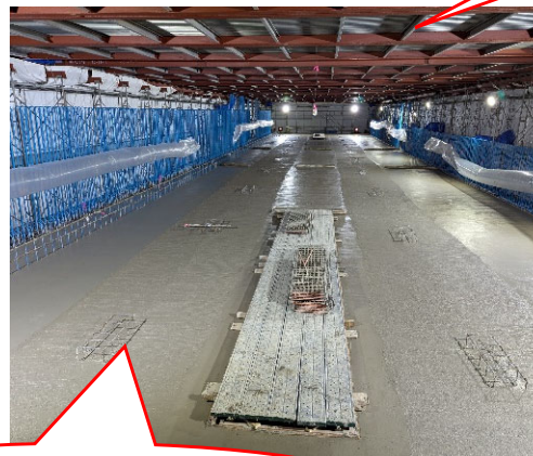
打設した生コンクリート (養生中は5℃以上に保つ)
