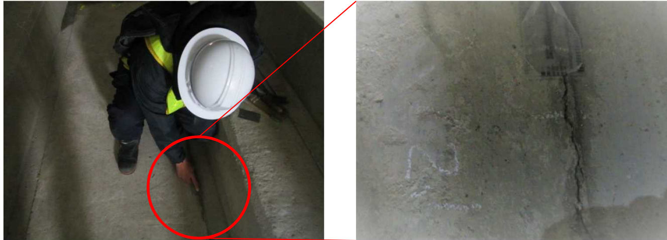
写真① 加賀トンネル(北) 392km900m付近
