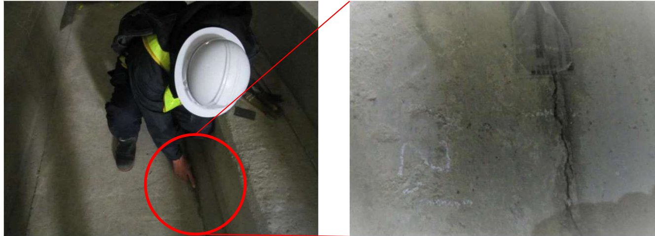
写真① 加賀トンネル(北) 392km900m付近
