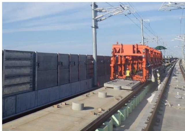
スラブ運搬敷設車により、軌道スラブを設置している状況
