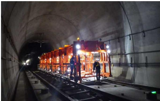
スラブ運搬敷設車により軌道スラブを敷設している状況
