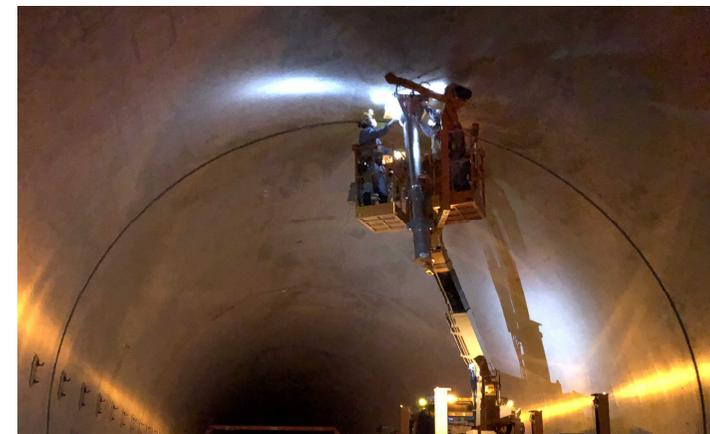
工事用機械を使用して、トンネル内で電車線を張るための支持物を設置している状況
