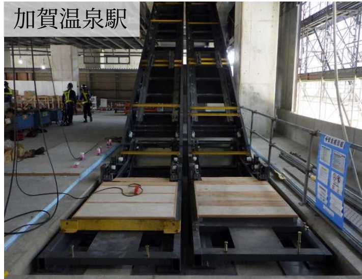
コンコース (上りホーム側) エスカレーター設置工事中
