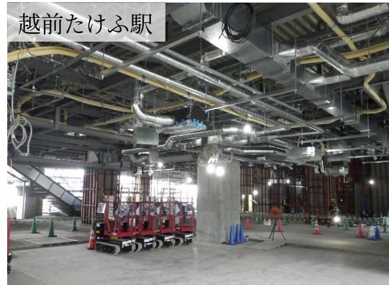
駅事務室エリア (改札横) 空調機器設置工事中
