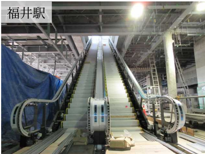
第一コンコース (金沢方) エスカレーター設置工事中
