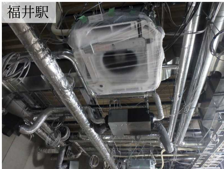
駅事務室 空調設備 エアコン室内機設置
