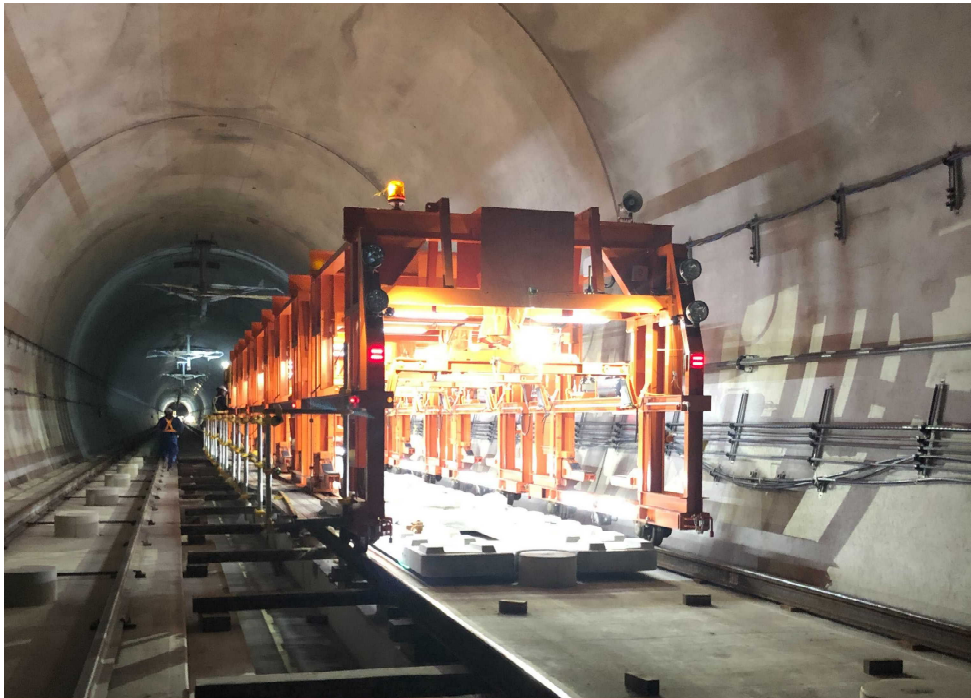
↑ 軌道スラブの運搬、敷設
