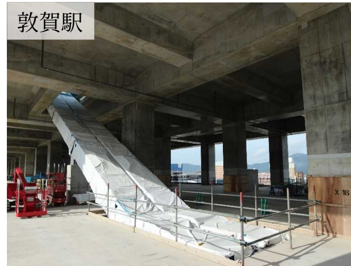
コンコース (下りホーム側) エスカレーター トラス設置
