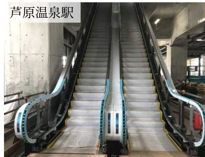
コンコース (下りホーム側) エスカレーター 踏段設置
